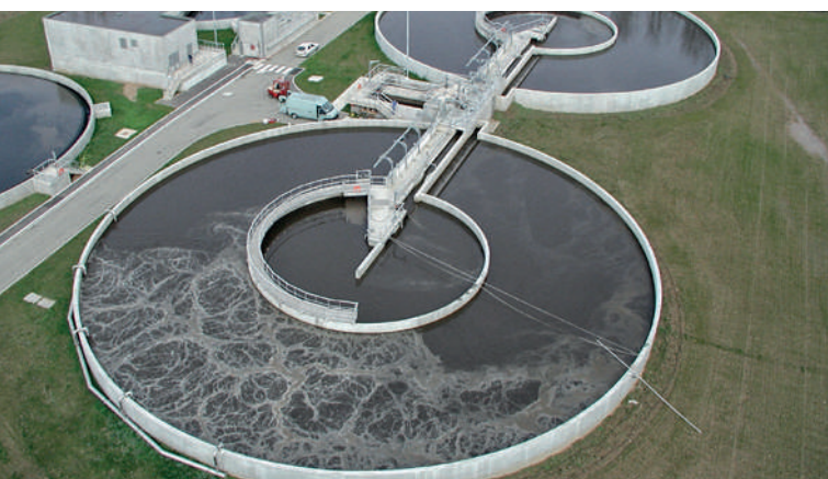
Ci-dessus : Station d'épuration à boues activées © IRSTEA
