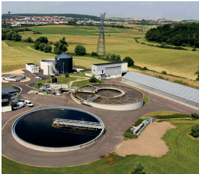
Ci-dessous : Station d'épuration Commune de Folschviller © Droits réservés
